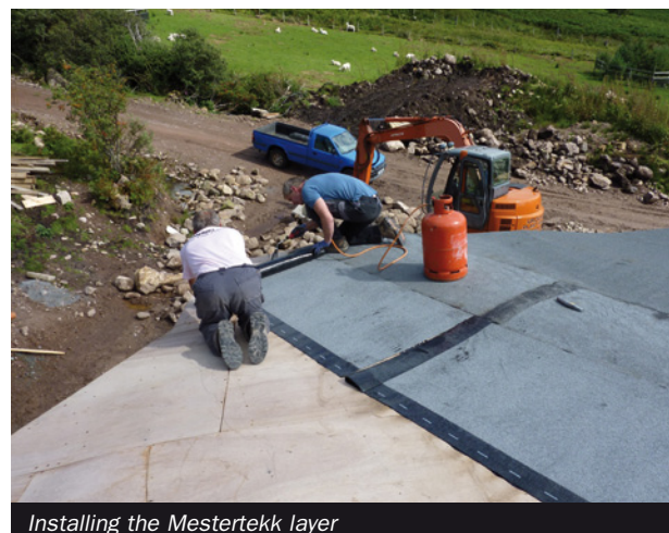
Installing the Mestertekk layer
